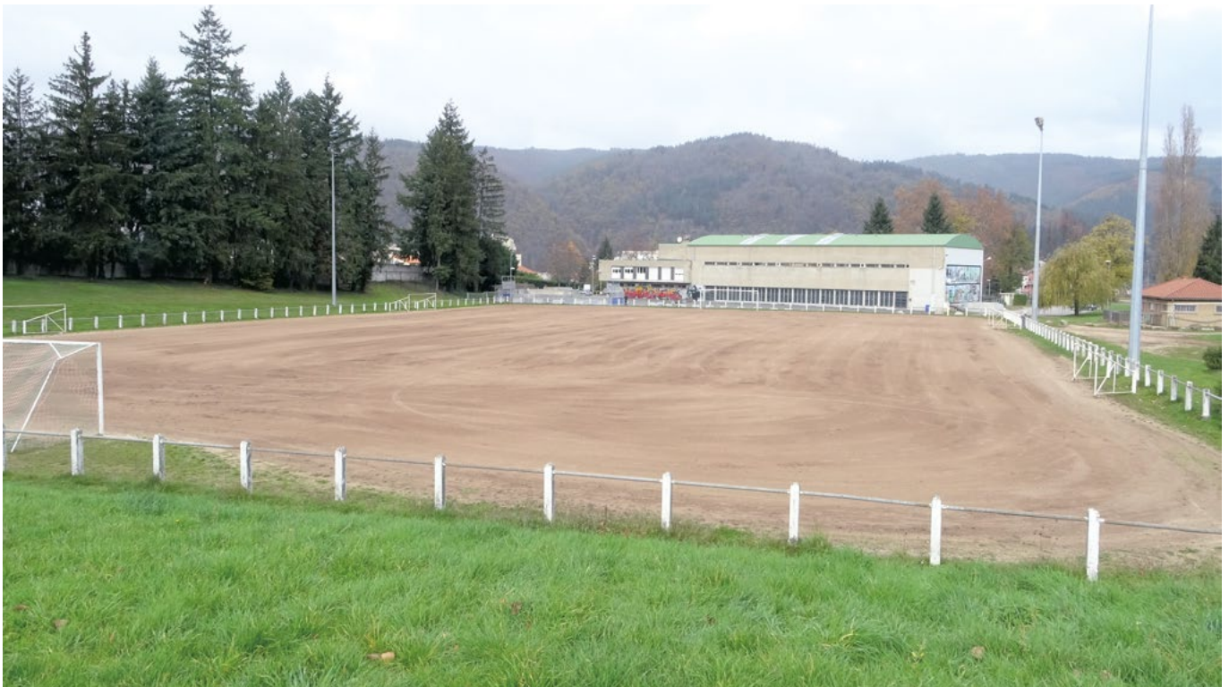
L'entretien courant d'un terrain en stabilisé consiste à passer avec une herse pour uniformiser la surface de jeu et supprimer les adventives. Ici à Aurec-sur-Loire (43), commune labellisée Terre Saine et engagée dans la Charte d'Entretien des Espaces Publics. ©F.LUCAS, FREDON AURA
