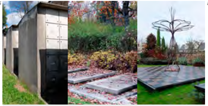
6 - Ossuaire, construction en élévation avec des casiers. Cimetière de Loyasse Lyon (69). 7 - Caveaux béton utilisés comme ossuaire. Cimetière intercommunal de Dijon (21). 8 - Ossuaire enterré avec sculpture en élévation. Cimetière de l'Est Rennes (35). © P&C - Sandrine LARRAMENDY 2016
