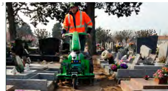
3 - Un agent prépare la surface d'une allée en vue de son prochain enherbement. Ville de Tours (37). © Ville de Tours - Olivier MASSAT et Fabienne BILLON date inconnue
