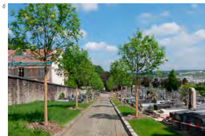
6 - Allée du cimetière des Gonards à Versailles (78) récemment réhabilitée : largeur réduite, remplacement de la surface en enrobé par des pavés de récupération, accotements enherbés, arbres plantés. La surface imperméable à désherber a été diminuée. © P&C - Sandrine LARRAMENDY 2016
