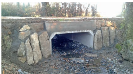
Pont-cadre franchissant le ruisseau du Chaintreau (44)
