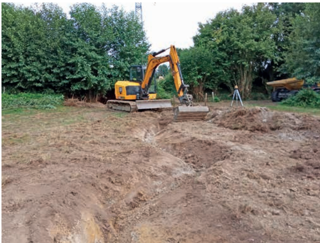
Le chantier au lieu-dit Les Forgineaux à La Petite Boissière (79)
