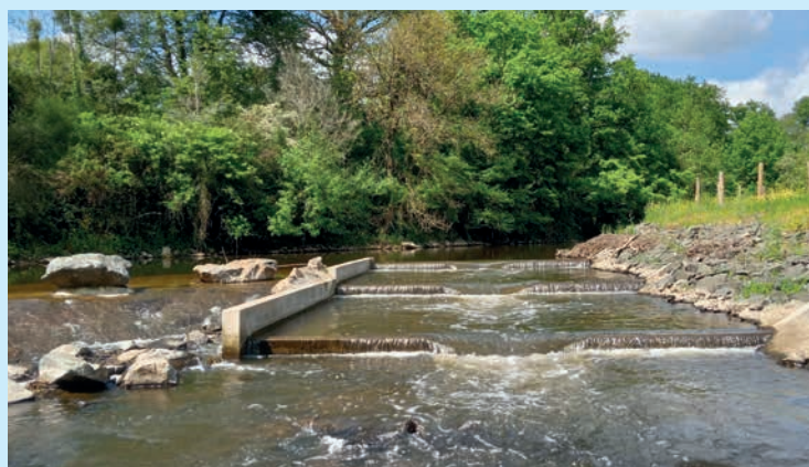
Passes à poissons au droit du Moulin Cassé (44)
