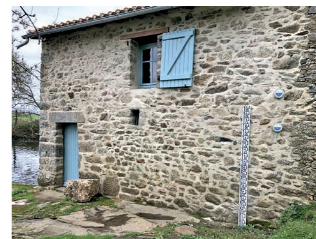
Les deux nouveaux repères de crue de Moulin Heudin
