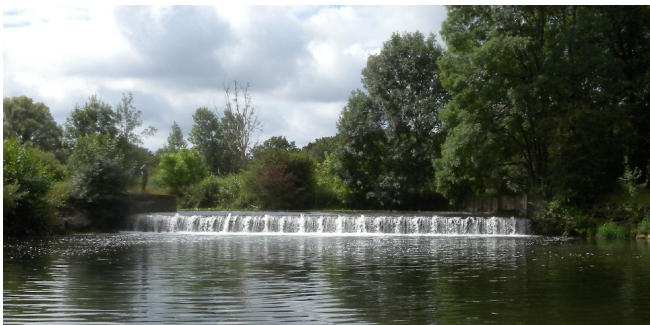
Ill. 23: A) Barrage de Grangent sur la Loire. Source non connue ; B) Seuil sur l'Indre © S.Braud
