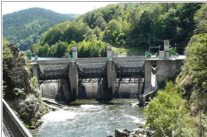
Ill. 43: Barrage de Poutès © Bernard Bost
