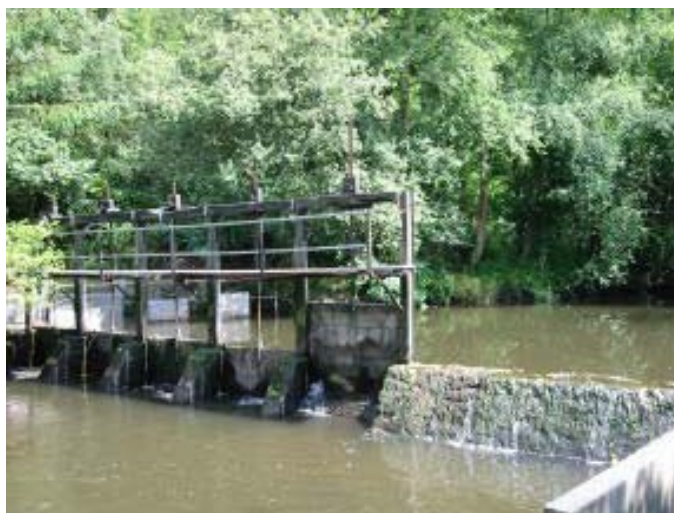
III. 24: Seuil à vannes © J.R. Malavoi
