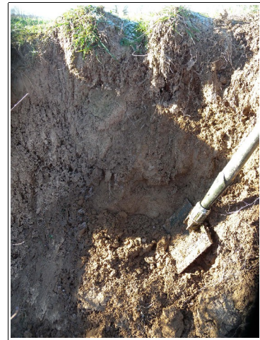
Ill. 59: Dégagement du pied de berge © S. Braud
