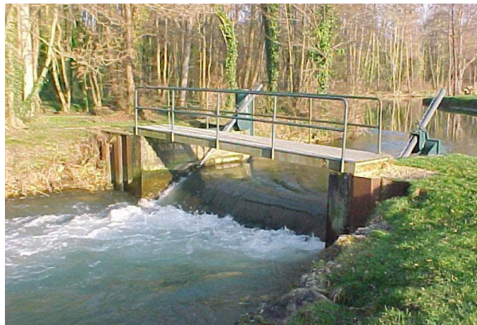
III. 25: Seuil à clapet © J.R. Malavoi
