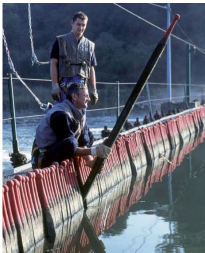
III. 26: « Barrage » à aiguille © CETMEF
