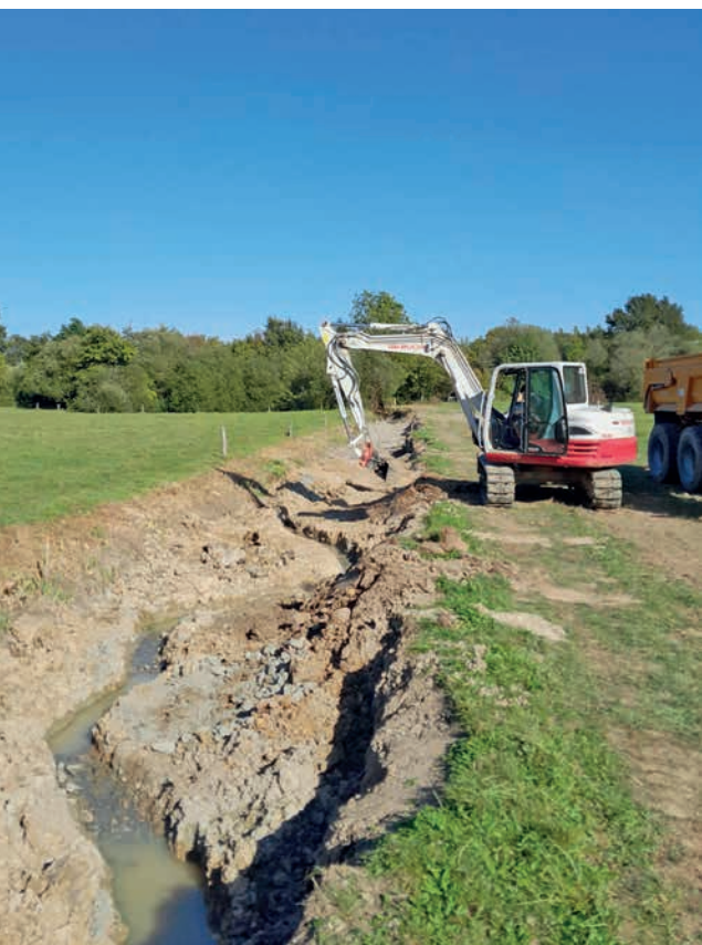
Travaux de restauration d'un cours d'eau sur la Sèvre amont
