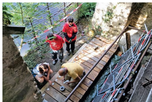
Fabrication de la passerelle du canal usinier
