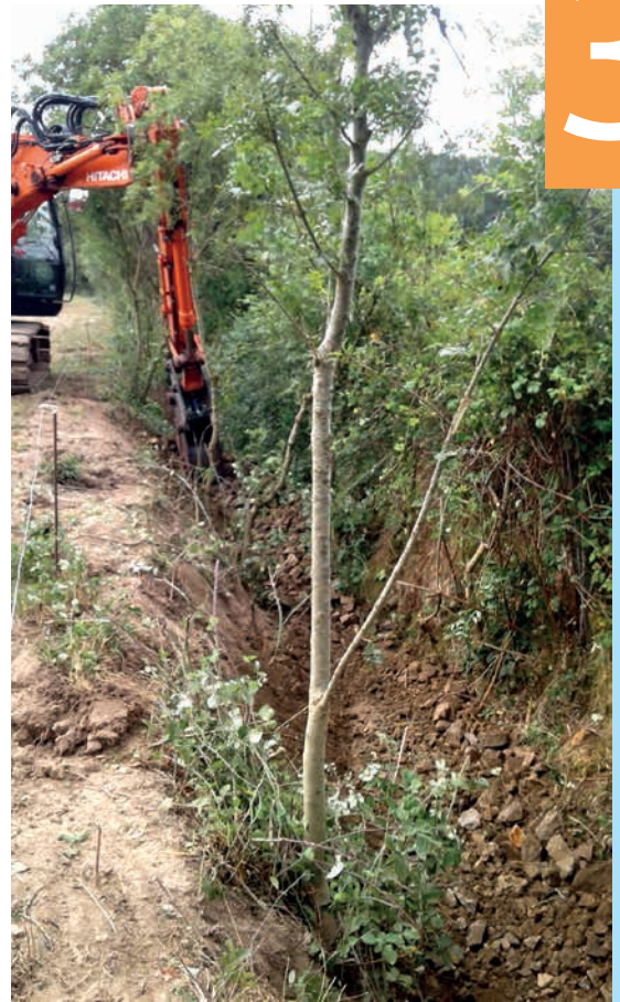
Traitement de la ripisylve sur un affluent du Trézon (49)
