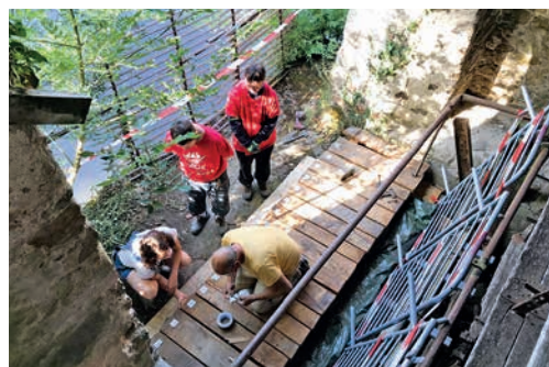
Fabrication de la passerelle du canal usinier
