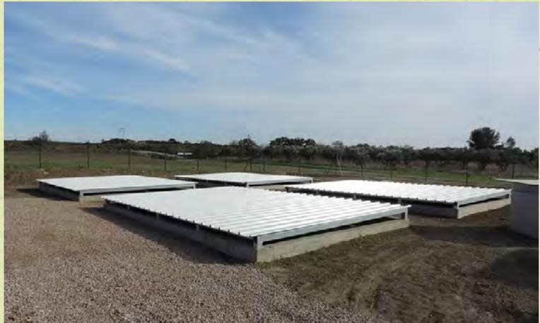
*La conception des aires de remplissage et lavage des pulvérisateurs permet de limiter la pollution des eaux et du milieu, à l'image de celle mise à disposition par la commune de Laurens, qui propose un système de remplissage des cuves de pulvérisateurs par le haut pour éviter le retour vers le réseau (photo de gauche) et des lits de traitements biologiques des eaux contaminées récupérées à l'issue du rinçage (photo de droite). / Commune de Laurens*
