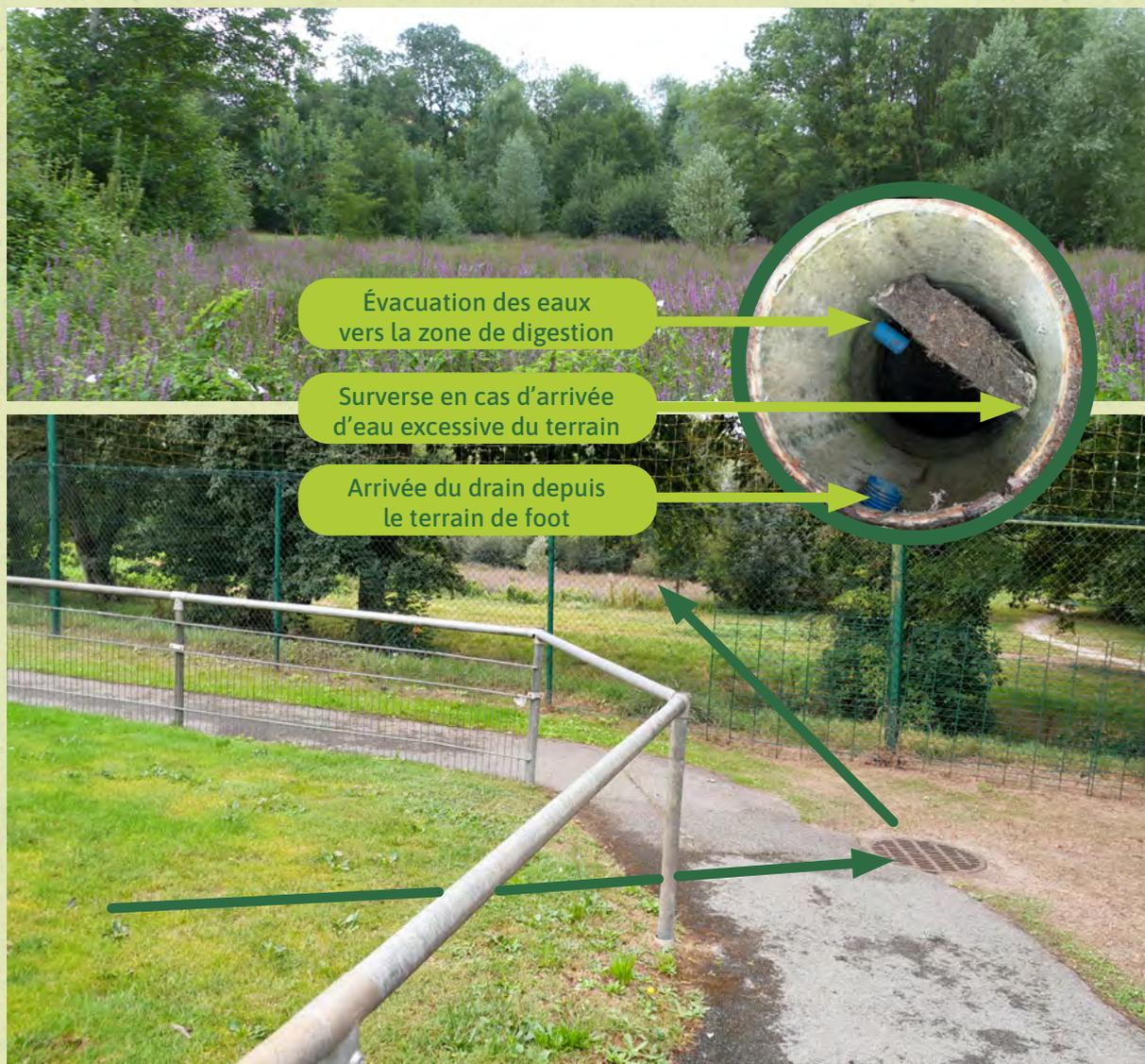
Un drain dirige les eaux de drainage du terrain de sport jusqu'à un regard permettant leur évacuation vers la zone de lagunage pour digestion avant leur écoulement vers le cours d'eau. / Bedhomme R, commune de La-Roche-sur-Yon
