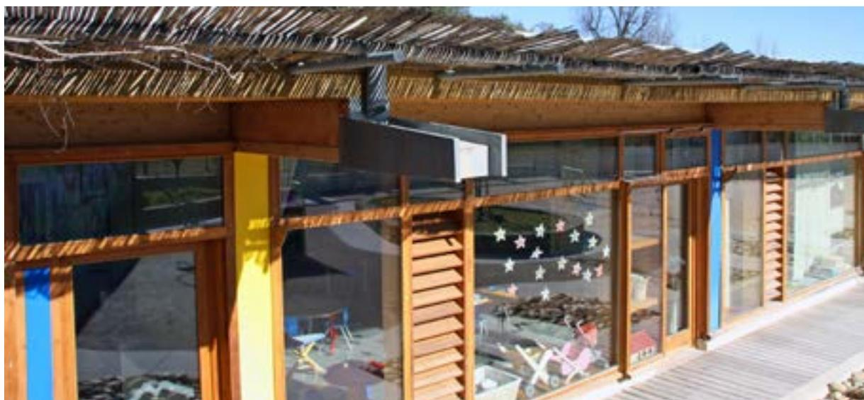
Des gargouilles laissent l'eau des toitures éclabousser les galets (école de Monoblet – Architecte : Yves Perret)
