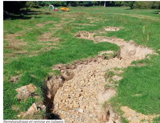
Reméandrage et remise en talweg
