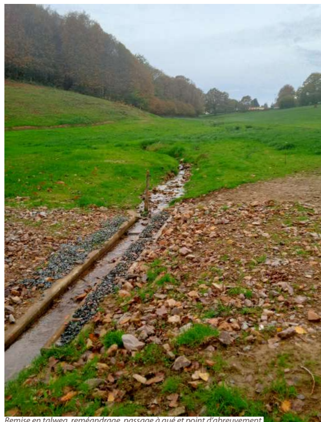
Remise en talweg, reméandrage, passage à gué et point d'abreuvement
