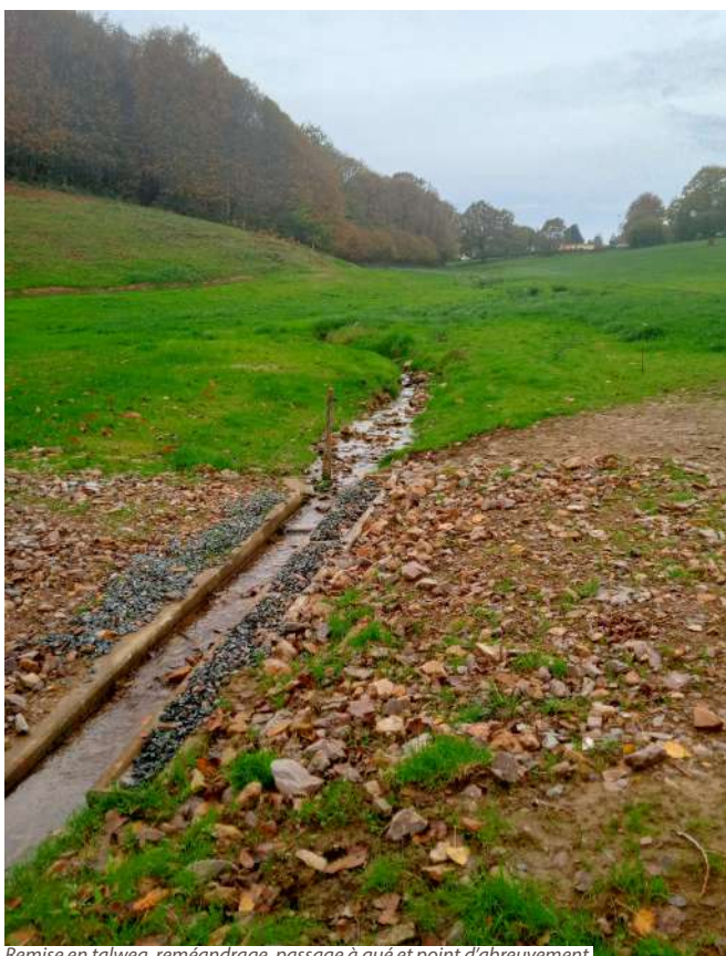
Remise en talweg, reméandrage, passage à gué et point d'abreuvement
