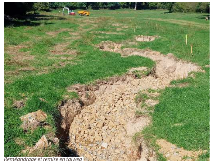
Reméandrage et remise en talweg
