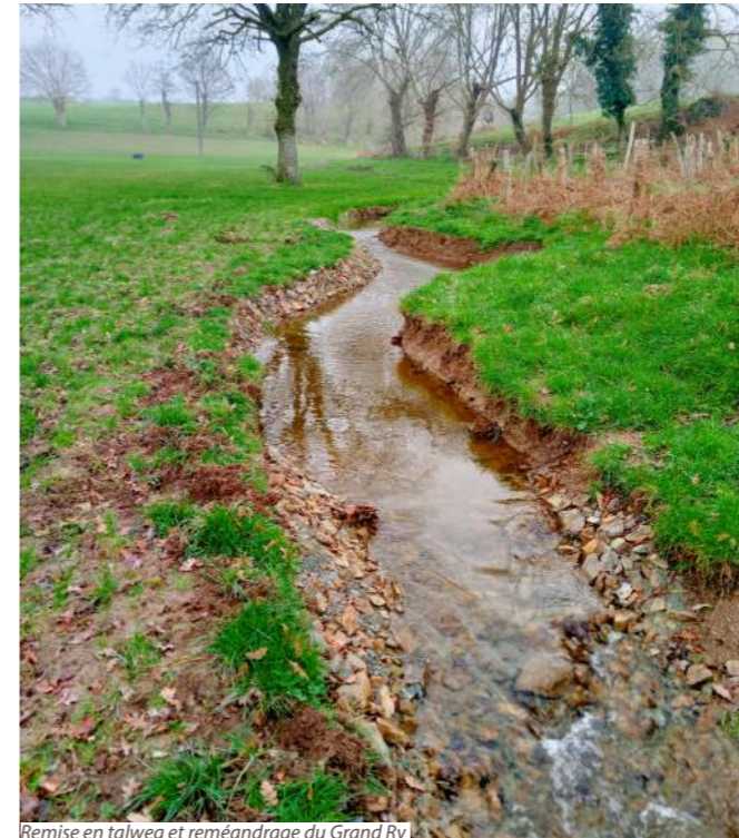
Remise en talweg et reméandrage du Grand Ry.
