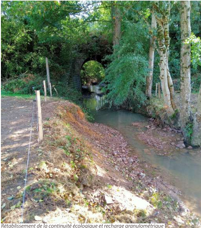
Rétablissement de la continuité écologique et recharge granulométrique
