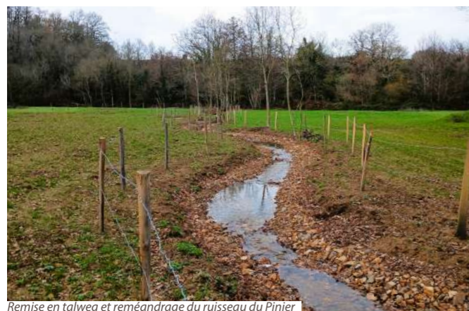
Remise en talweg et reméandrage du ruisseau du Pinier
