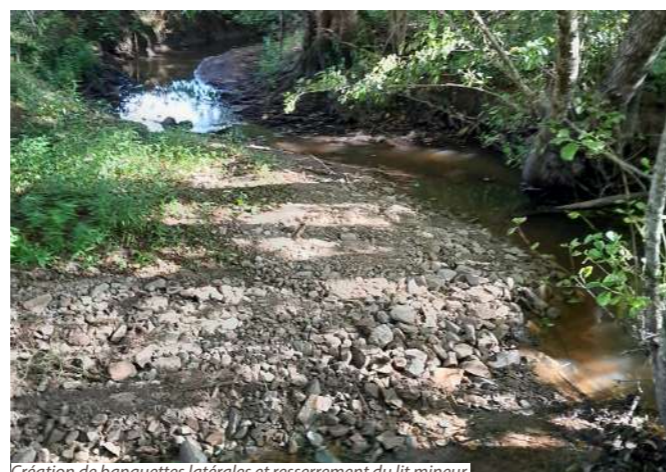
Création de banquettes latérales et resserrement du lit mineur.
