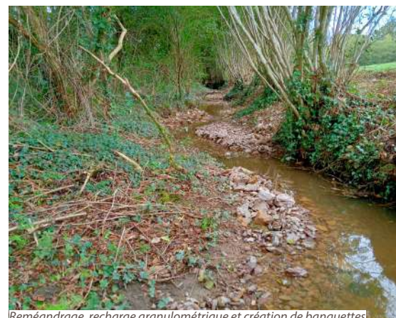
Reméandrage, recharge granulométrique et création de banquettes
