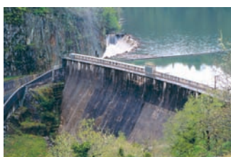
Barrage hydroélectrique de Pont de Salars sur le Viour
