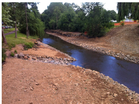
Effacement du seuil du Parc de Moine et aménagement d'un pluvial en rive droite - juin 2012
